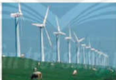
Điện gió Bình Thuận
